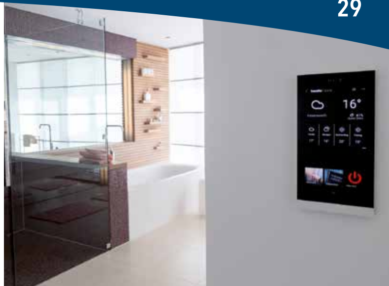
Wohlfühlfaktor durch intelligente Steuerung: Bedienung von Musik, Licht, Beschattung, Türsprechanlage und Klima über ein Touchpanel.
