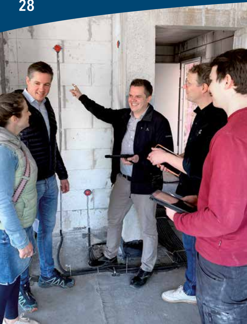
Baustellenbesprechung: Teamarbeit für Kunden von RET sieht man hier bei einer Baustellenbesprechung mit den Bauherren und anderen Gewerken.
