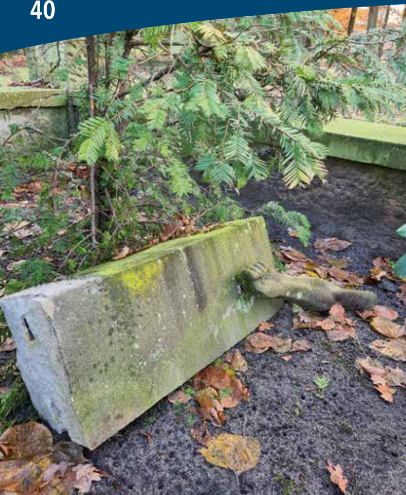
Links: Das Querelement des Hochkreuz zerbrach durch die Rostspaltung in zwei solcher Teile.
