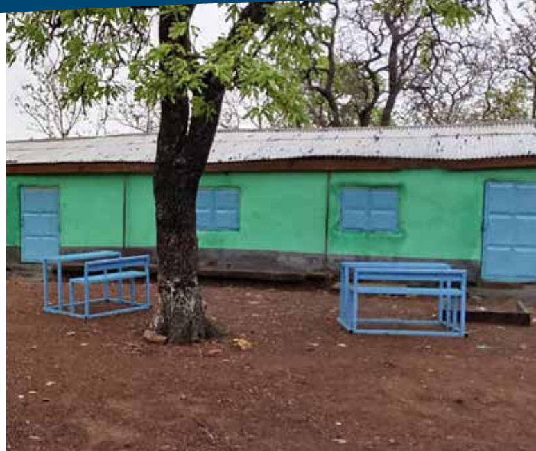
Oben: Das neue Dach der Schule in Sanssayiri bietet wieder Schutz vor dem Regen.
