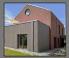
Zweifamilienhaus mit Klinker- und Holzfassade
