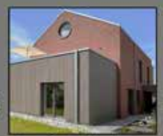
Zweifamilienhaus mit Klinker- und Holzfassade
